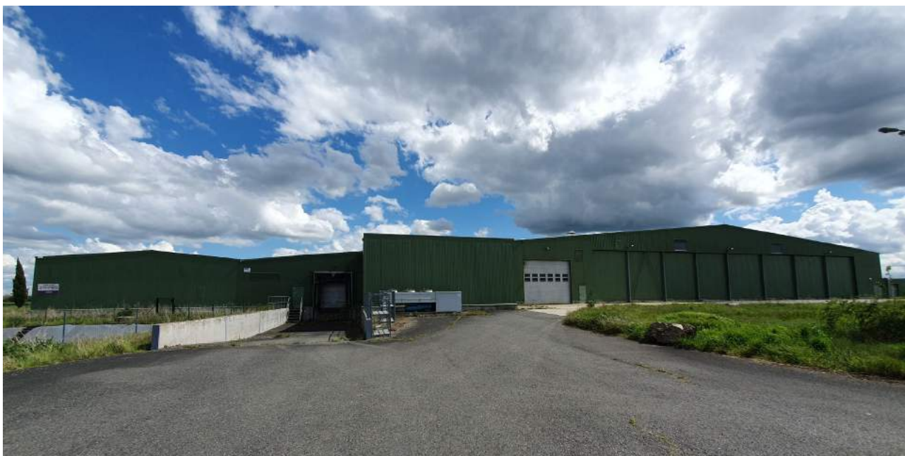
Figure 19. Photographie du bâtiment d'activité présent sur le STECAL Ay1
